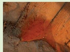
Spores couleur rouille de la mérule piégées par une toile d'araignée, véritable foyer pour de prochaines germinations et infestations.
