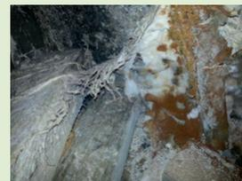
Envahissement progressif, massif et rapide du mycélium de la mérule, dont on aperçoit ici les syringes à gauche et l'immense surface occupée par le sporophore
